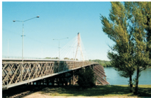
Rys. 2.4. Widok mostu składanego MS-54
