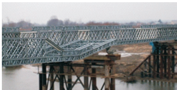
Rys. 2.8. Widok nasuwania mostu DMS-65
